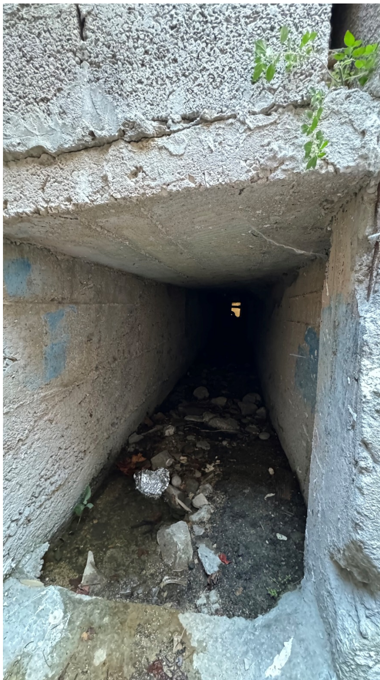
Slika 15: Prikaz kanala za atmosfersku vodu bez adekvatne hidroizolacije
