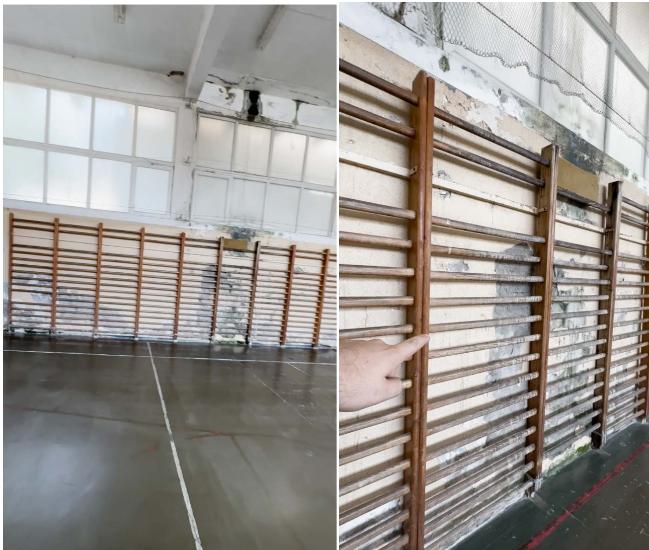
Slika 14: Prikaz stanja postojećih zidova uslijed nedostatka adekvatne hidroizolacije i drenaže ukopanog zida na sjevernoj fasadi
